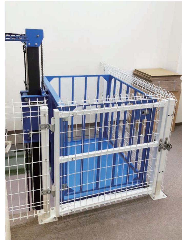
リフト周りの囲い (2階上部) ※1
